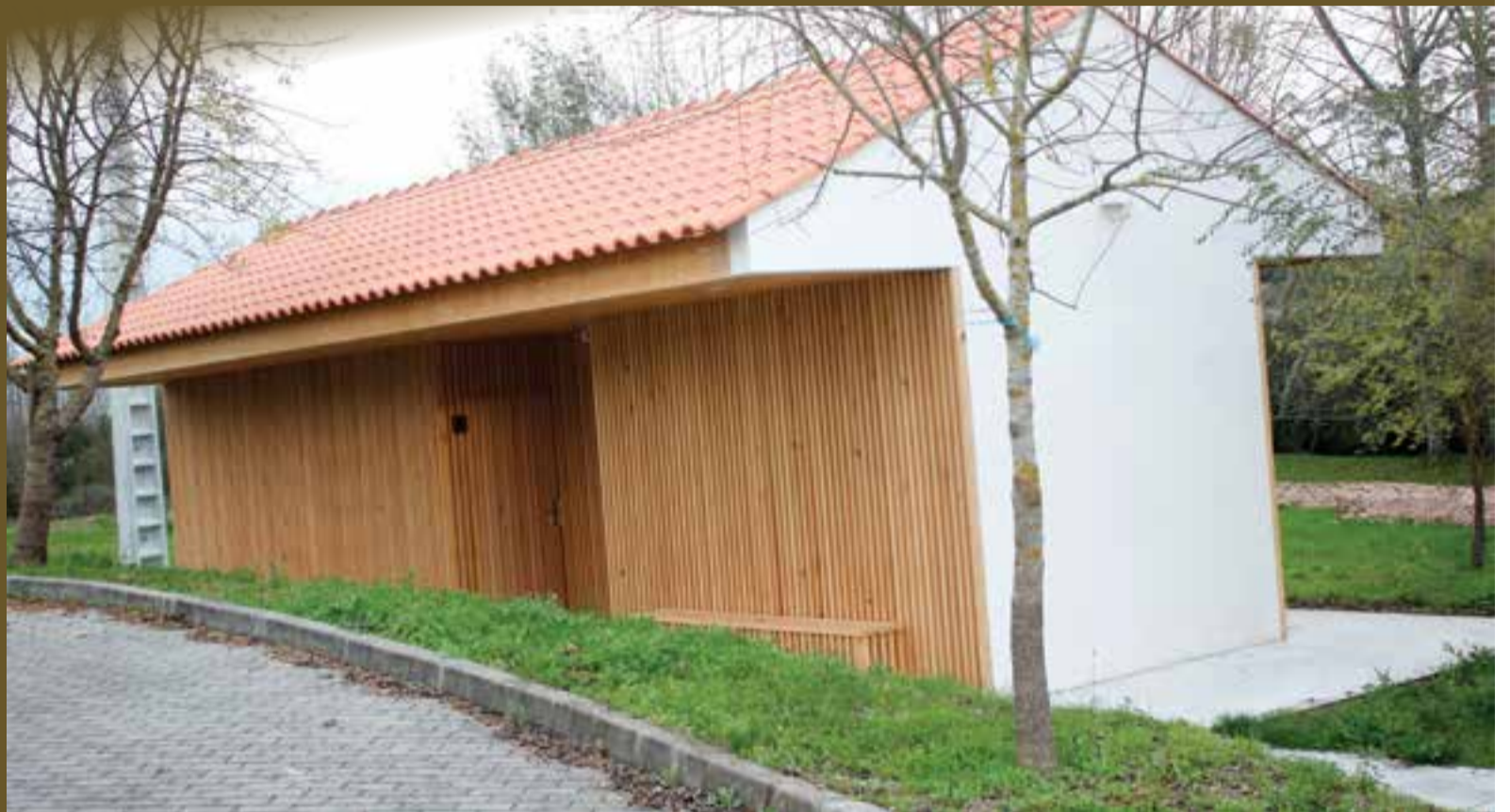
• A conclusão das instalações sanitárias do Parque Verde foi uma das obras marcantes do ano que terminou
