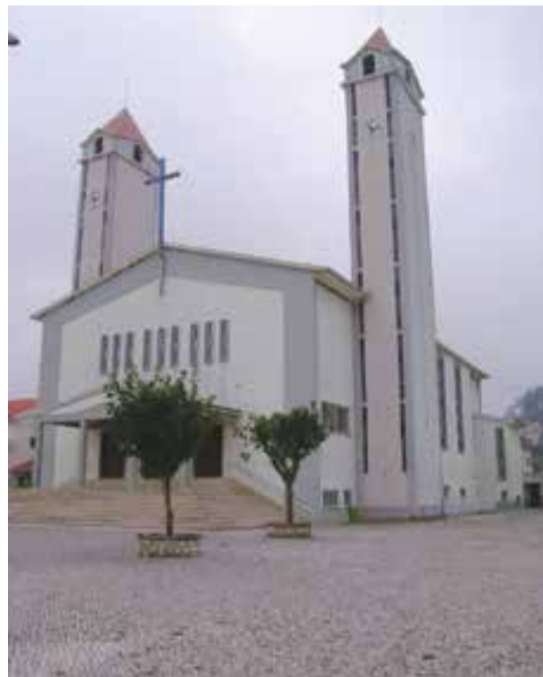
• 20 mil euros destinam-se à requalificação da zona envolvente à Igreja Nova
